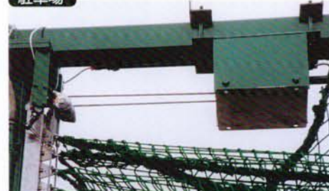
車輛出入り用ネット式ゲート(車輛衝突時の衝撃緩和用)
