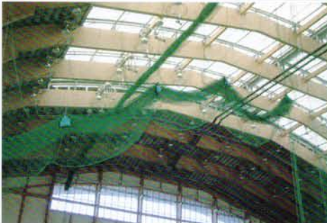
急傾斜の屋根勾配に沿って間仕切ネットを上下させる。ネットの収納は屋根に沿って行われる。(弊社特許取得済)(電動GS-100を使用)
