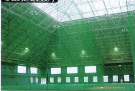
急傾斜の屋根勾配に沿ってカーテンネットを開閉させる。(電動GS-200を使用) PAT GSネットシステム
