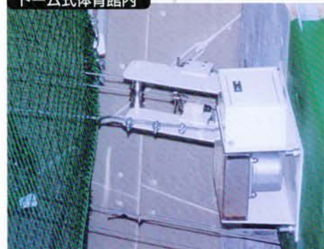
室内を必要に応じて分割する多目的ネットの持ち上げ用
