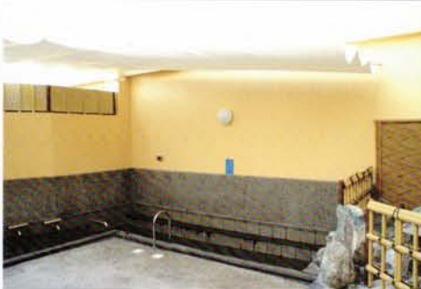
露天風呂のテント屋根の開閉に屋外ステンレス仕様を採用。(手動ハンドル式GSH-100を使用)
