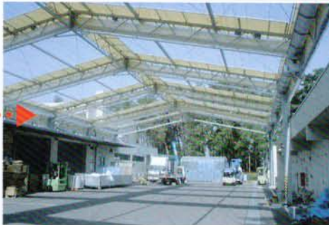
屋外テントを複数枚同時に一台のウインチにて稼動します。また、ワイヤーにテンション装置は必要ありません。(電動GS-200を使用)
