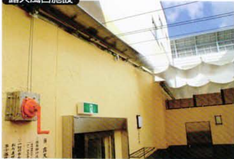
露天風呂のテント屋根の開閉に屋外ステンレス仕様を採用。(手動ハンドル式GSH-100を使用)
