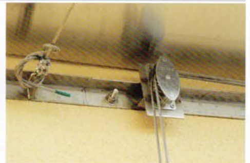
ワイヤーロープの効率的な配置に滑車を使用。
